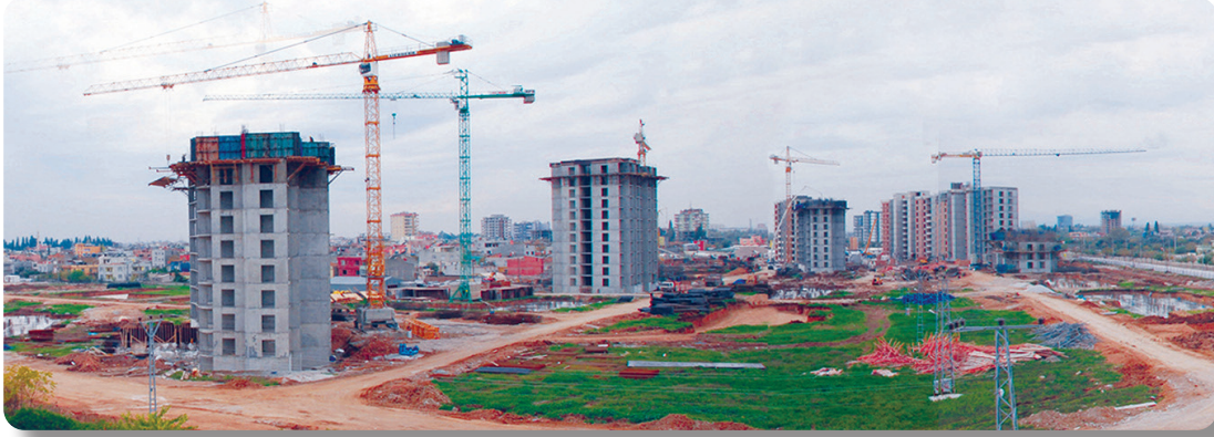
Resim 22. Seyhan, Kıyıkent Evleri Yapım Aşaması
