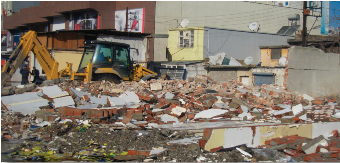
Resim 25. Belediyemiz Yıkım Çalışmaları
