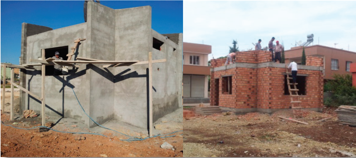
Resim 5. Belediyemizin Muhtarlık Binası Yapım Çalışmaları
