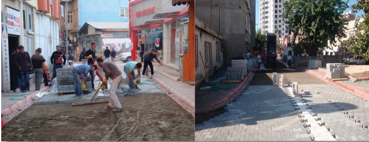
Resim 3. Belediyemizin Parke Yol ve Kaldırım Çalışmaları
