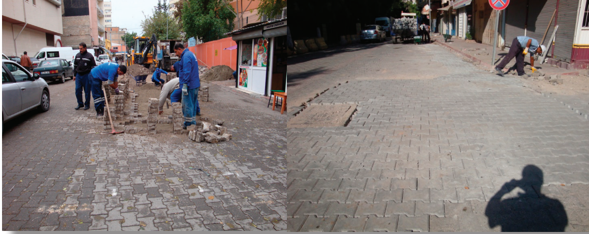
Resim 4. Belediyemizin Parke Yol ve Kaldırım Tadilatı Çalışmaları
