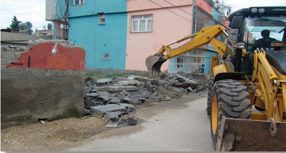
Resim 23. Belediyemiz Yıkım Çalışmaları
