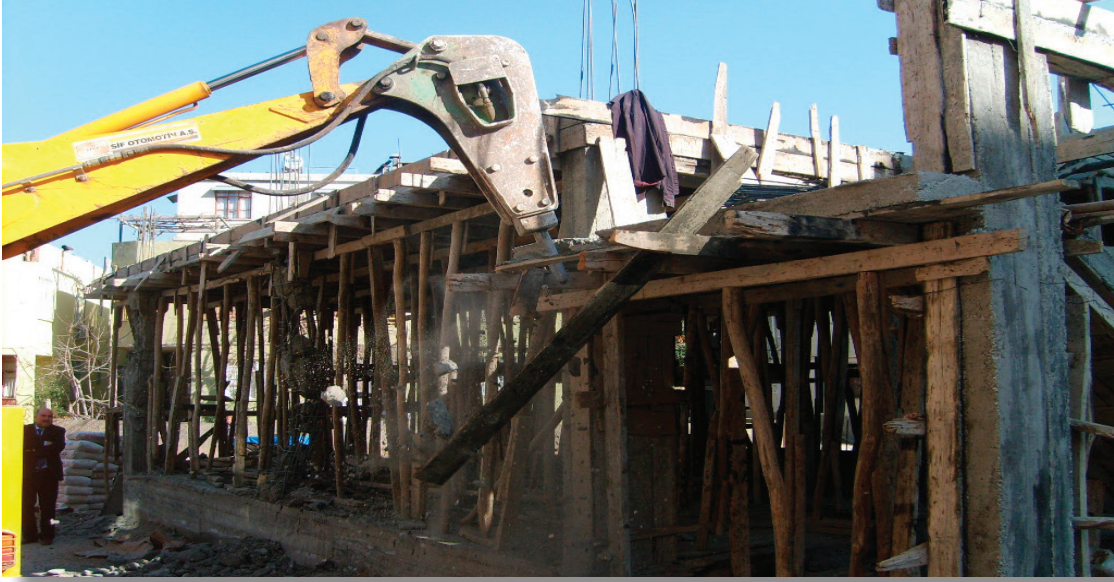
Resim 24. Belediyemiz Yıkım Çalışmaları
