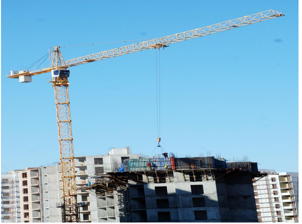
Resim 64. 16.01.2013 Kıyıkent Kentsel Yenileme Projesi
