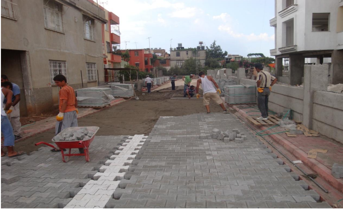
Resim 5. Parke yol yapım ve bakım çalışmaları
