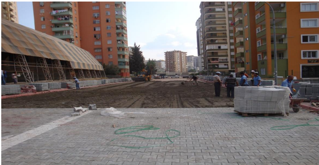
Resim 4. Parke Yol Yapım Çalışmaları
